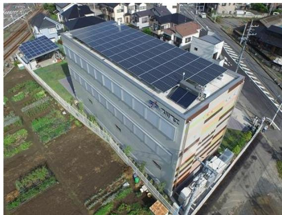
屋上設置発電設備(19kW)
