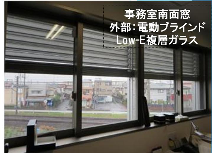
高性能遮熱断熱サッシ・ガラス
